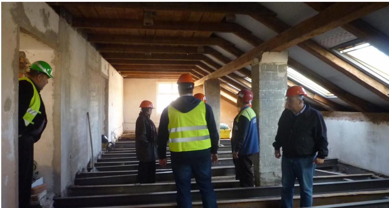
Kontrolní den na stavbě
